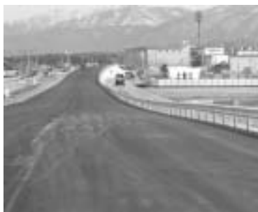
▲ 最終段階に入った工事現場の様子 中多良南交差点付近(2月28日撮影)
