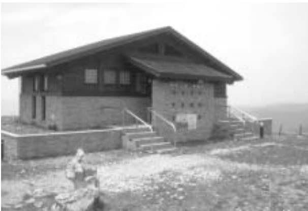
▲大規模修繕が必要な山頂公衆便所
