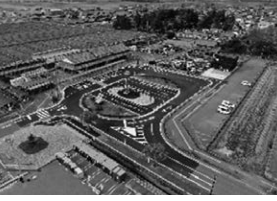
【坂田駅前広場整備工事】
