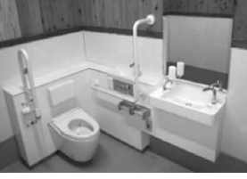
【大原小学校トイレ改修工事】
