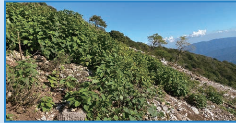
試験施工1年後の状況(2024年10月11日)土のう筋工の効果で斜面が安定し、植生が回復してきています。
