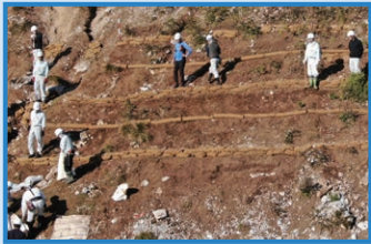
7合目付近で実施した土のう筋工試験施工時の状況(2023年10月18日)
