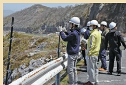
侵入防止柵設置作業の様子
