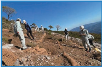
7合目付近で実施した土のう筋工試験施工時の状況(2023年10月18日)
