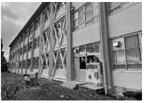
【双葉中学校長寿命化改良工事】
