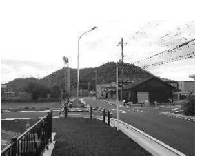
【市道顔戸八田羽織線改良工事】
