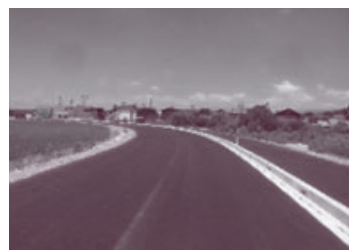
市道顔戸八田羽織線道路改良工事▲
