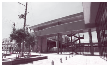
連絡通路の整備▲
