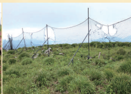
シカに壊されたネット柵
