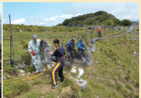
ネット柵の張替え作業
