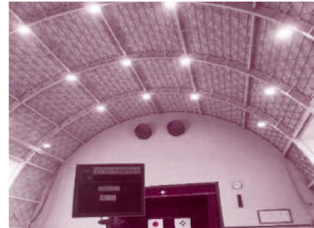
米原小学校体育館照明改修工事▲
