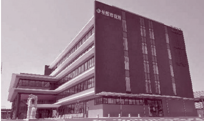
市役所本庁舎の整備▲
