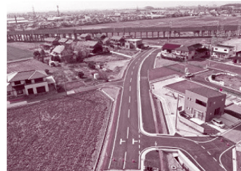
市道顔戸八田羽織線道路改良工事▲
