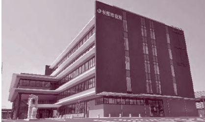
市役所本庁舎の整備▲
