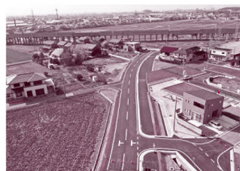
市道顔戸八田羽織線道路改良工事▲
