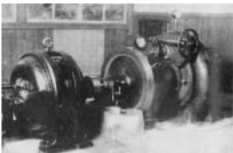
◀ 醒井養鱒場で利用されていたタービン型発電機（醒井養鱒場提供）
