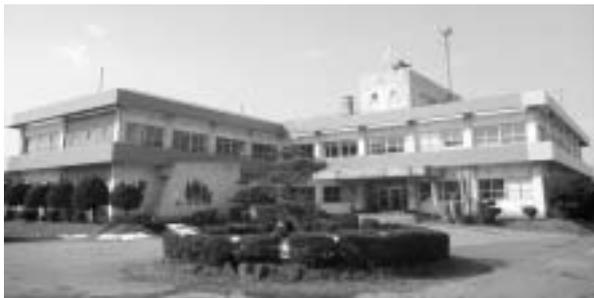
米原庁舎は耐震診断の結果、1階部分で耐震安全性が低く、倒壊、または崩壊する危険性があります。
