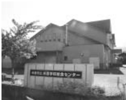
改修工事を行う米原給食センター
