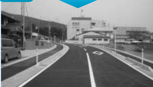
2車線に拡幅し利便性が向上 歩道も整備し歩行者の安全性を確保
