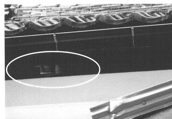
蔵の屋根支材㉑
