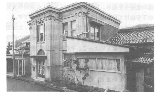
旧醒井郵便局局舎全景
