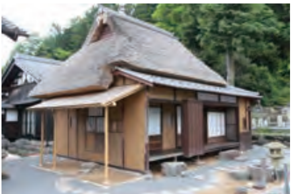
◆旧田中家新座敷棟（長岡）
