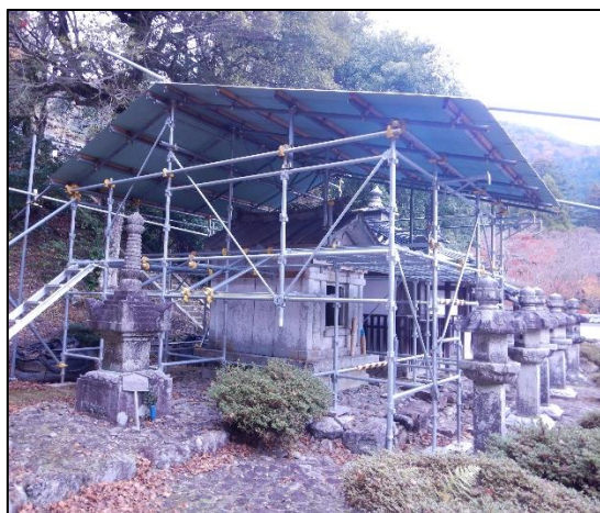
③京極高次石廟内 左：保護覆屋を架けた石廟外観 右：石廟内は狭く、円筒濾紙と温湿度データロガは床の上に設置した（現在は高さ 30cm の台上に設置している）。
