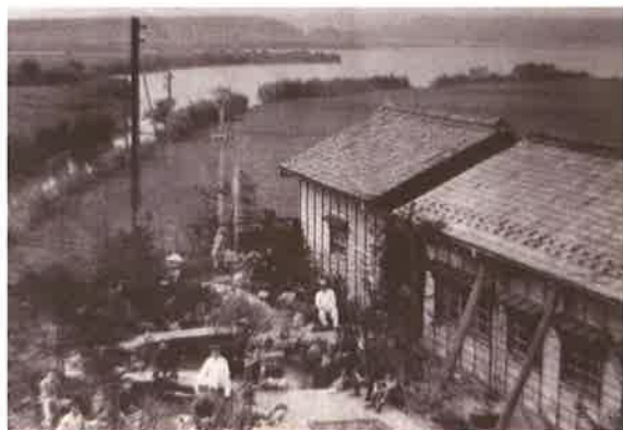
入江内湖の様子（米原駅付近から）
