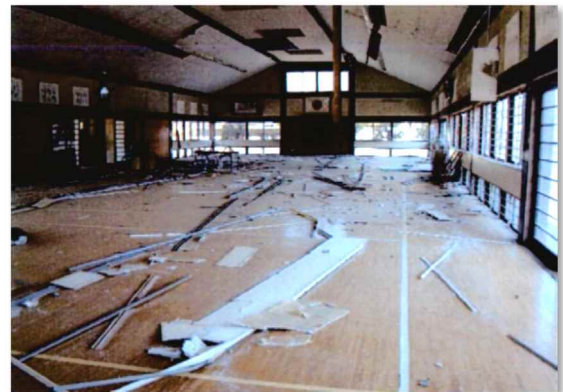
東日本大震災で天井材が落下した事例 (左：屋内運動場／宮城県 右：格技場／茨城県) (写真は「東日本大震災の被害を踏まえた学校施設の整備」より)
