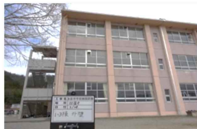
校舎外壁（双葉中学校）
