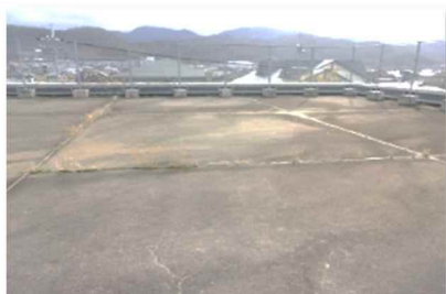
校舎屋上（米原小学校）
