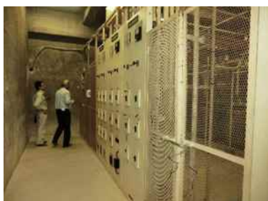
設備機器の具体例（左：分電盤 中央：変圧器・コンデンサ等 右：熱電設備）
