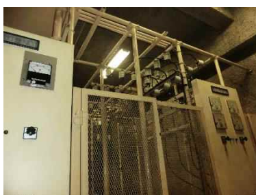
設備機器の具体例（左：分電盤 中央：変圧器・コンデンサ等 右：熱電設備）
