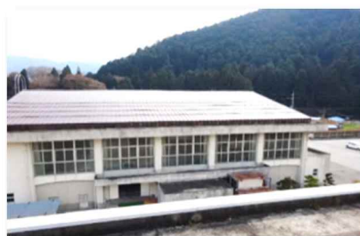
屋内運動場屋根（柏原中学校）
