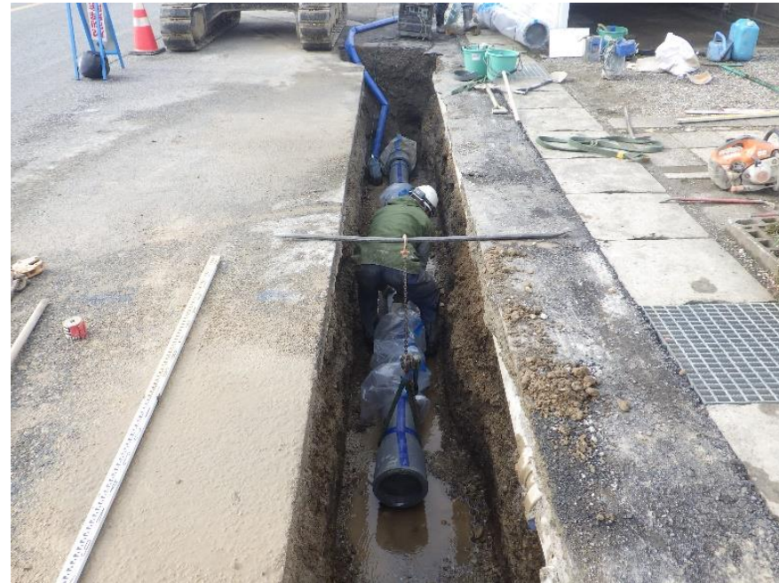
工事概要: GX形ダクタイル鉄管φ200 L=277.9m
