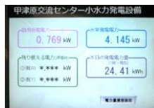
甲津原交流センター 小水力発電設備
