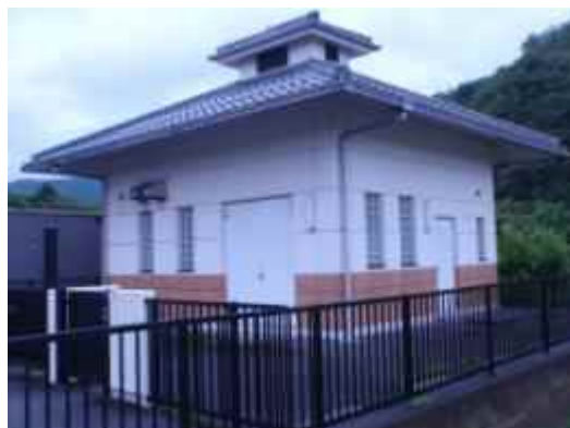
↑ 公共下水道 寺倉真空ステーション
