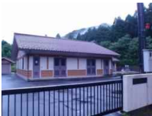
↑ 梓河内農業集落排水処理施設
