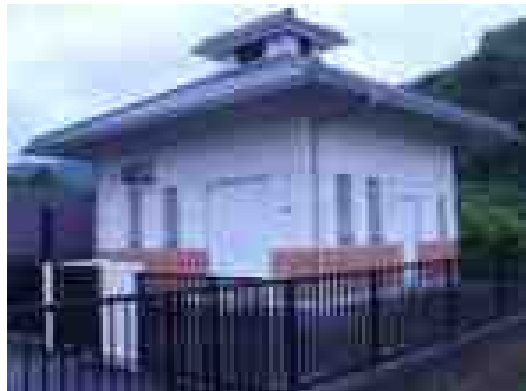
↑ 公共下水道 寺倉真空ステーション
