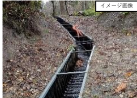
流路工・水路工
