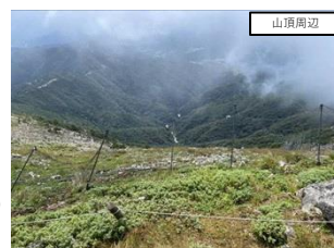
シカ侵入防止柵
