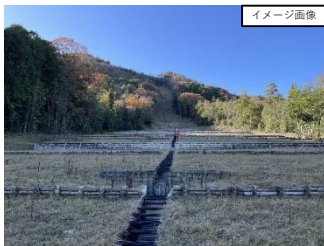
土留工+水路工
