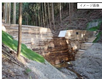
コンクリートダム
