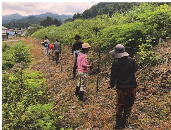
若手住民による獣害防護柵の設置作業
