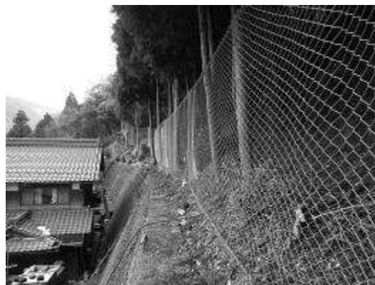
急傾斜地崩壊防止対策
