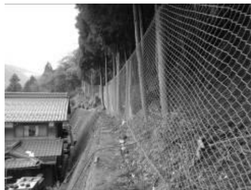
急傾斜地崩壊防止対策
