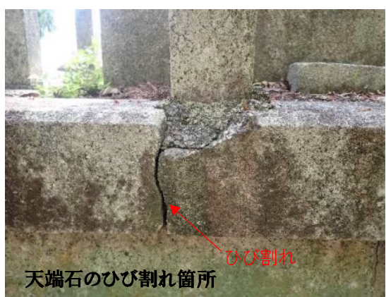
天端石のずれ、基壇の目地の開き
