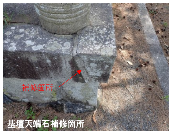
基礎部のひび割れ箇所
