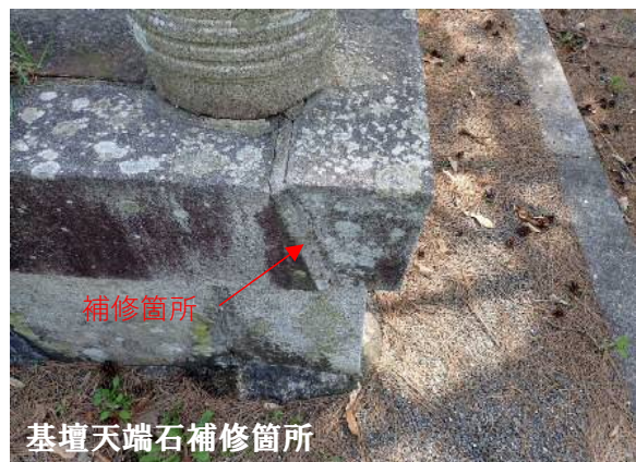
基礎部のひび割れ箇所
