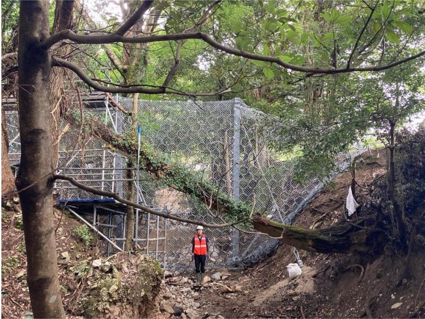
⑦上流部 H=5.0m L=24m 土砂捕捉量約 1,500 m<sup>3</sup>
