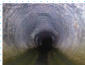
下水道管内の様子
