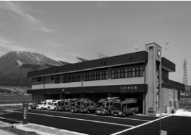
【米原消防署（新消防庁舎）】
