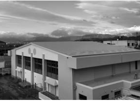
【坂田小学校長寿命化改良工事】
