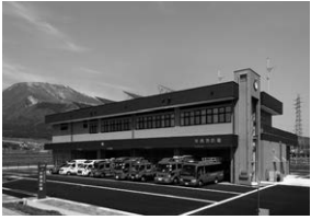
【米原消防署(新消防庁舎)】
