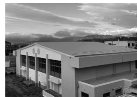
【坂田小学校長寿命化改良工事】
