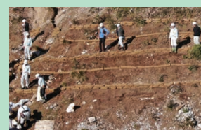
土のう筋工施工時 (2023年10月)
