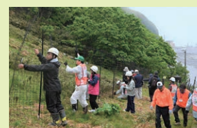
山頂での柵設置作業
