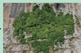
1年9カ月が経過し、施工部分に植物が生い茂ってきています。 (2025年7月)
