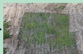
施工後10カ月、ネット内の植生が回復してきている様子が分かります。 (2025年7月)
