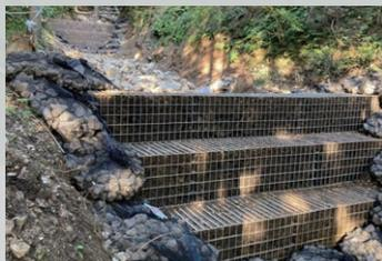
土砂の勢いを抑えるための土石流ガードを設置しました。
