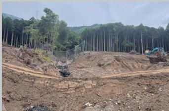
土砂をせき止めるためのえん堤を新設するほか、既設のえん堤の改修を進めています。(写真は新設工事中のえん堤)
