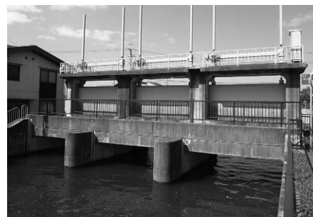
▲市内には入江と磯の2カ所にポンプ場があり、琵琶湖の水位を見守っています(写真は入江川樋門)
